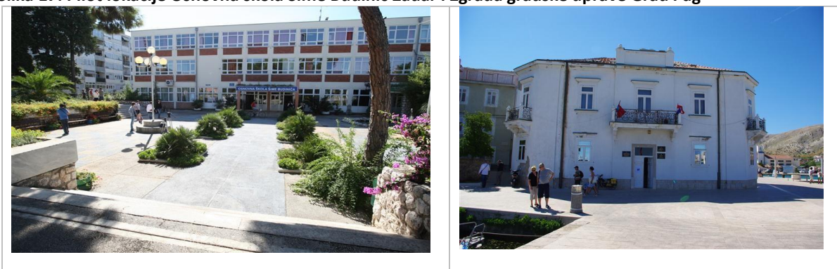
Slika 17: Pilot lokacije Osnovna škola Šime Budinić Zadar i Zgrada gradske uprave Grad Pag
